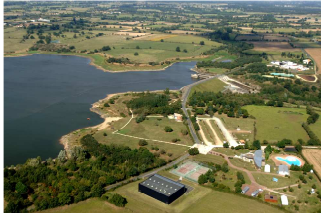
Vue aérienne de la retenue l du Cébron (CG 79)
