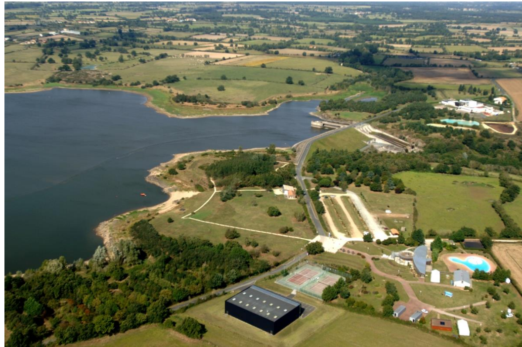
Vue aérienne de la retenue du Cébron (CG 79)
